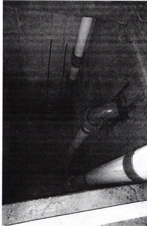
Foto 14. Tubería de sumergencia 250 mm.
